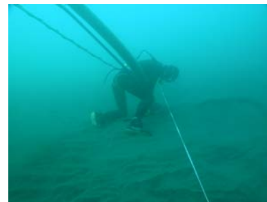
礫確認箇所についてエアリフトにより掘削(1m程度)
