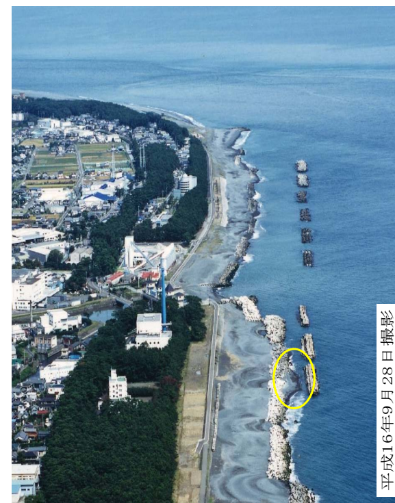
討議資料 図 2.1.3 航空写真による海岸線状況
