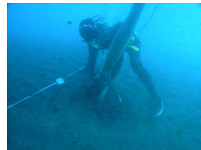
礫確認箇所についてエアリフトにより掘削(1m程度)
