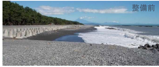
○養浜工(大井川工区の整備状況)
