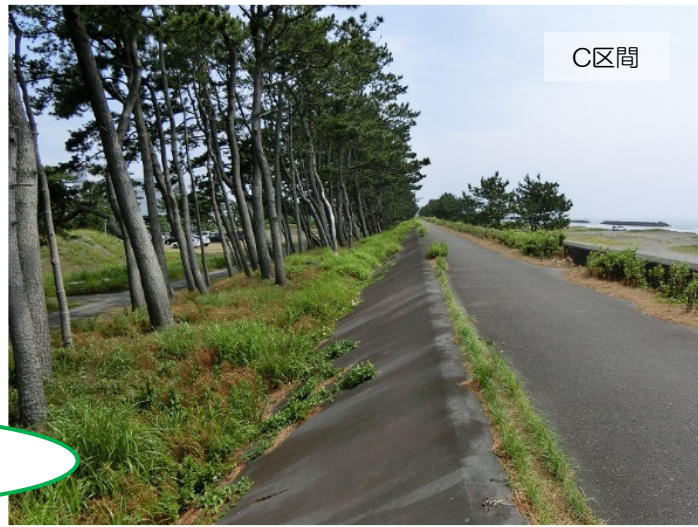
住吉工区の堤防裏法面の松の状況
