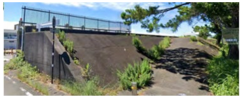
陸閘部堤防形状 (背後にスロープが設置されている)
