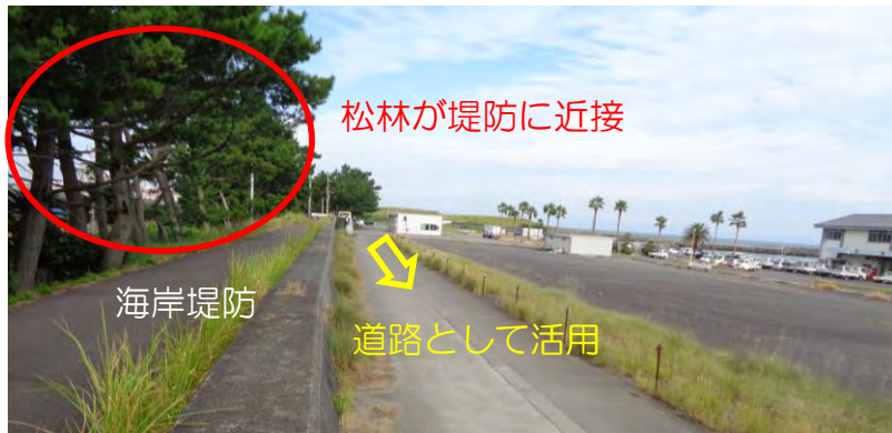
A区間-3の現地状況
