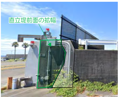
陸閘の側面写真
