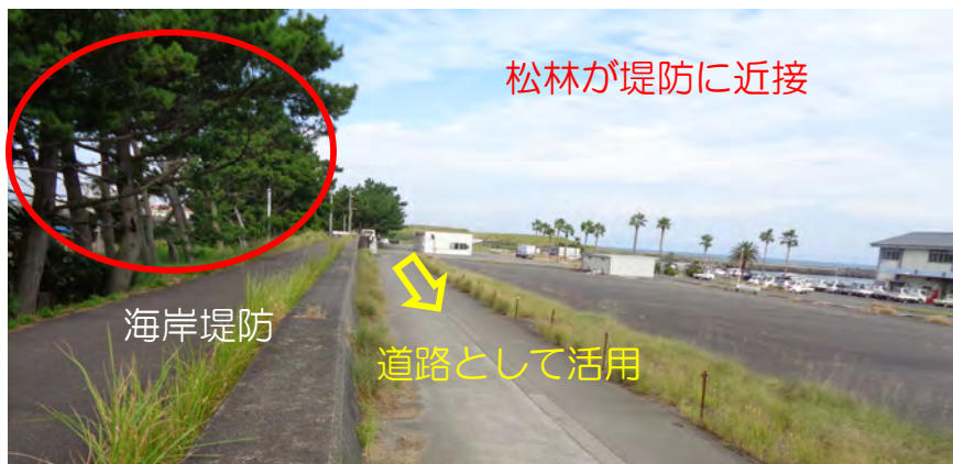
A区間-3の現地状況
