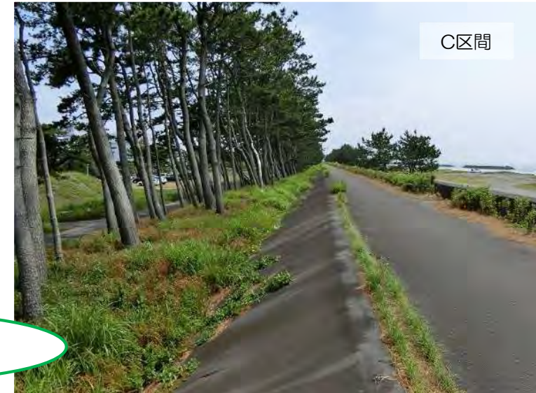
住吉工区の堤防裏法面の松の状況
