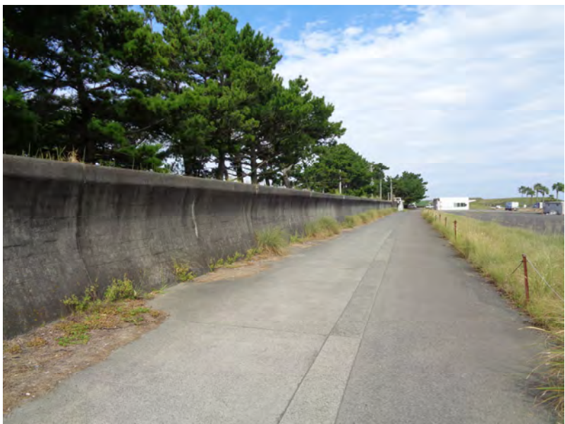
現地状況 (A区間-3)
