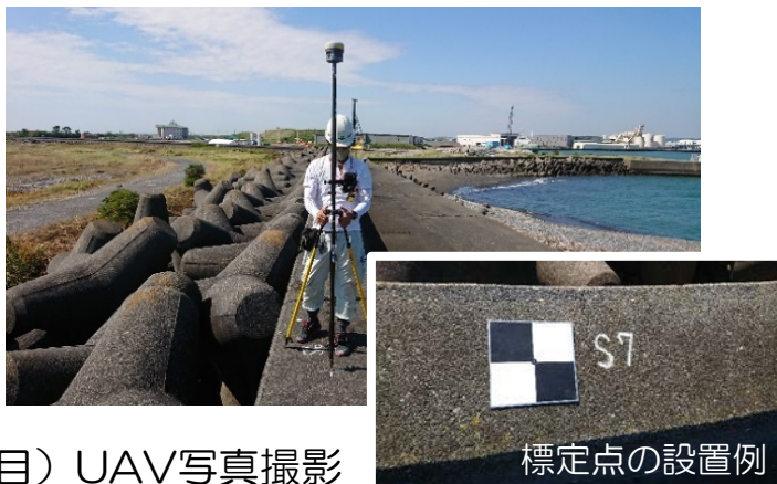
(1日目) RTK-GPS測量による標定点の設置
