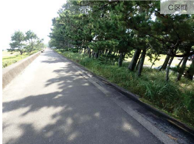
住吉工区の堤防裏法面の松の状況
