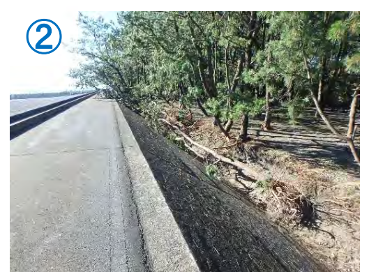
No.11+50付近 焼津工区 (13日 8:23)
