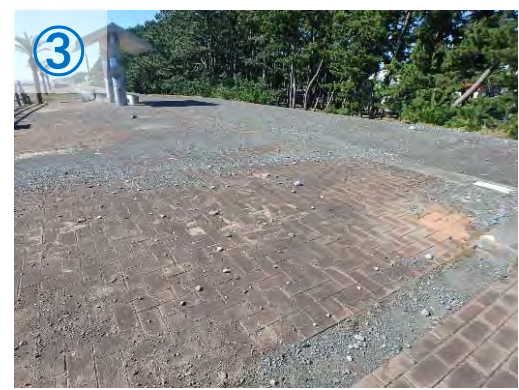
No.19付近 焼津工区 (13日 9:50)
