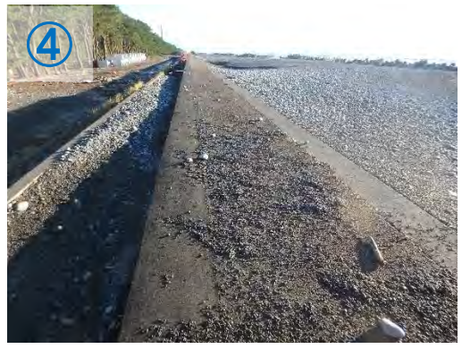
No.27付近 大井川工区 (13日 6:45)
