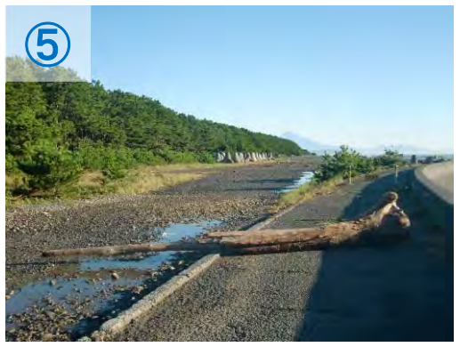
No.41+80 大井川工区 (13日 7:29)
