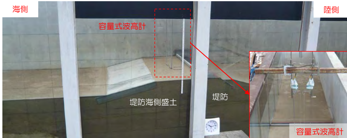
容量式波高計の設置状況
