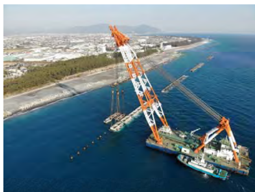
【S-VHS 有脚式離岸堤 (H31.1)】
