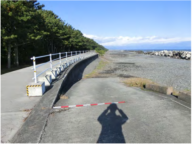
藤森川河口部に設置されている転落防止柵
