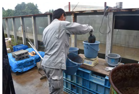
盛土用土砂の含水比調整の様子
