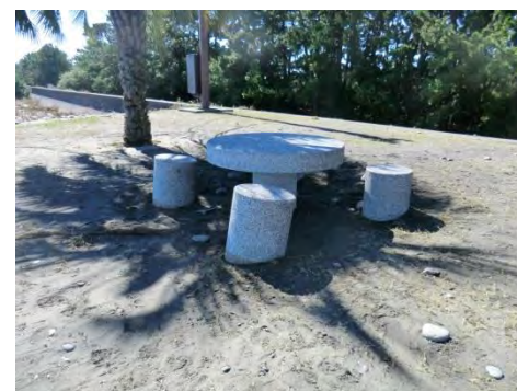
天端占用施設周り流出痕確認 焼津工区
