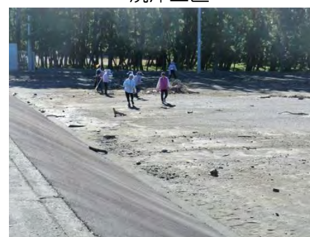
堤防裏グラウンドに流木散乱 大井川工区
