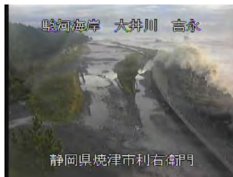
No.41付近 大井川工区
