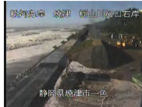
No.22付近 焼津工区
