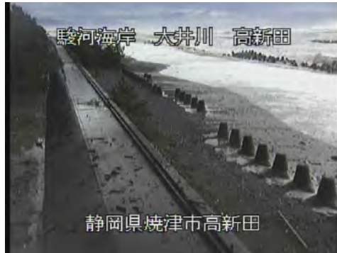
No.35付近 大井川工区
