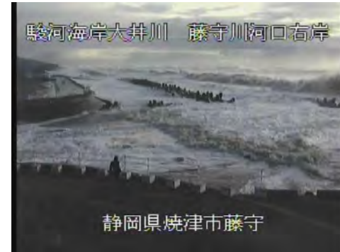
No.29付近 藤守川河口 大井川工区
