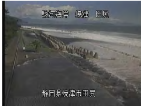
No.13付近 焼津工区
