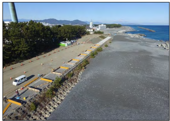
【焼津工区 (H29.12)】
