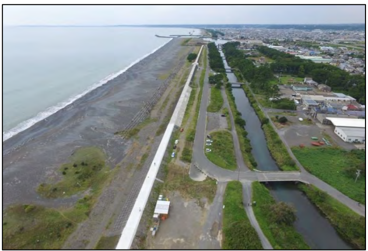
【川尻工区 (H29.12)】
