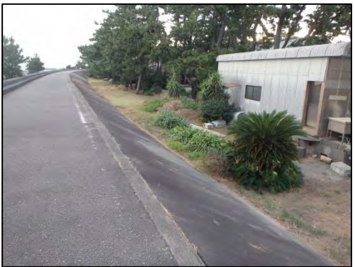
No.15付近の堤防背後の状況
