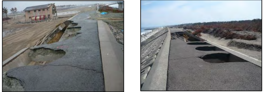
東日本大震災時のアスファルト舗装の被災状況
