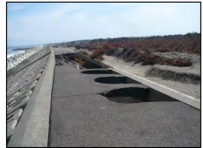
東日本大震災時のアスファルト構造部の被災状況
