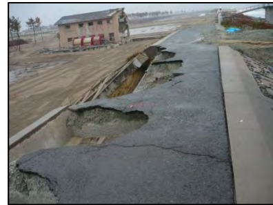
東日本大震災時のアスファルト構造部の被災状況
