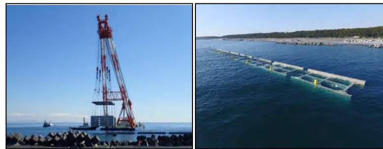
有脚式離岸堤
