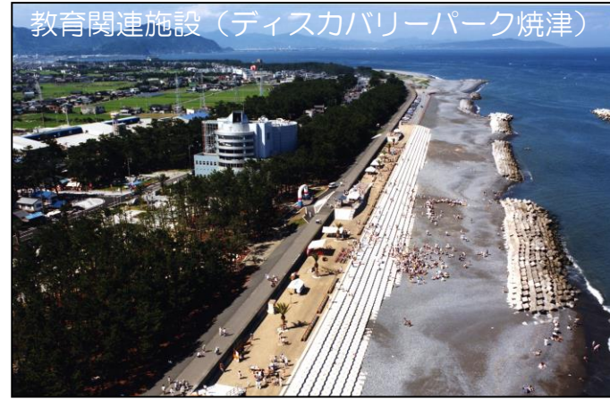
教育施設と一体で整備した海岸堤防（焼津工区）
