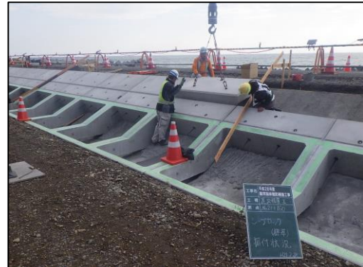
【粘り強い堤防[焼津工区] (H29.2)】
