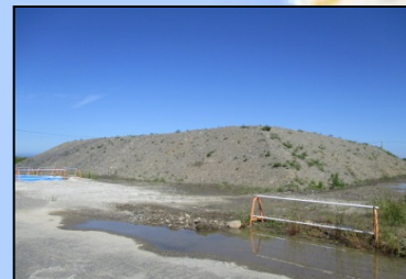
吉田町土砂仮置 (吉田漁港区域内)
