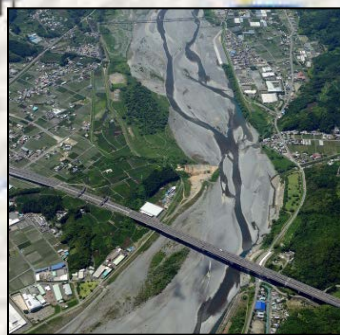
大井川河道掘削土(国)
