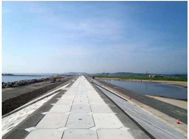
粘り強い海岸堤防構造の施工例（仙台湾南部海岸）
