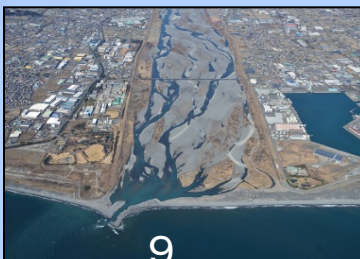
大井川河道掘削土(国)
