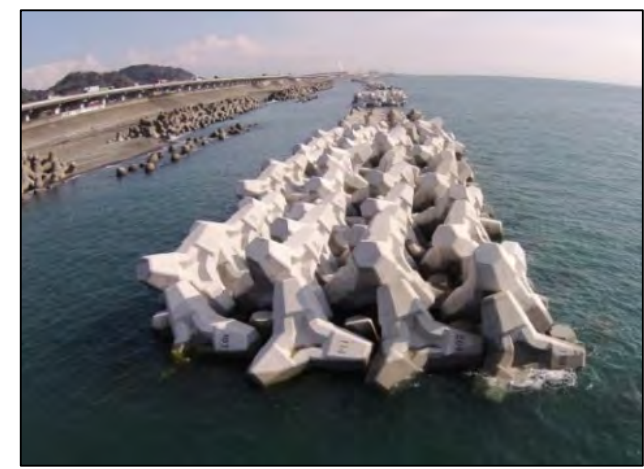
ブロック式離岸堤 整備イメージ
