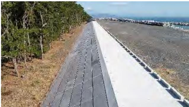
一般的な粘り強い構造の海岸堤防整備イメージ
