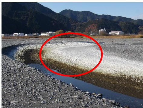
安西橋下流(5.75km付近)近景 令和6年12月26日の様子
