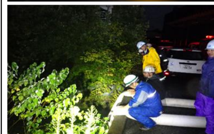
排水ポンプ車による排水作業の状況 (秋山川)
