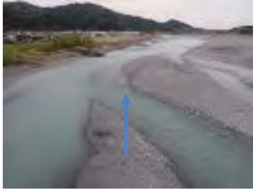
大井川用水水路橋下流側(21.0km付近)(3月23日)
