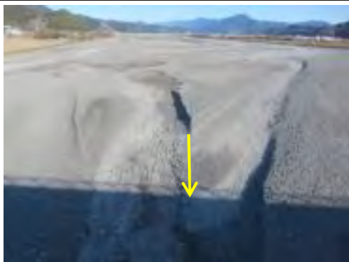
①R362 安西橋上流側付近 (6.0km) 令和5年1月26日の様子
