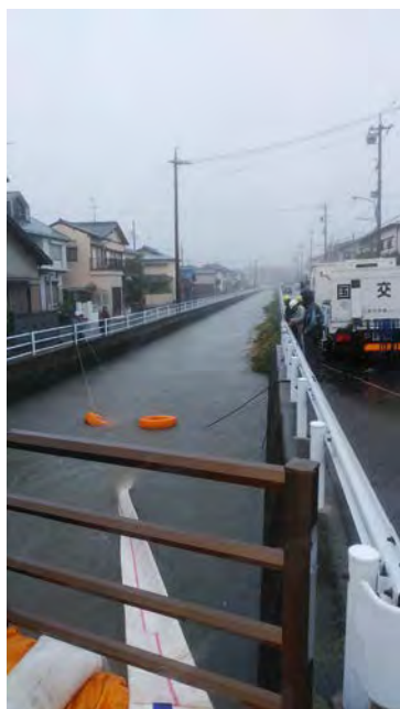
排水ポンプ車稼働状況 (静岡市駿河区西島地先)
