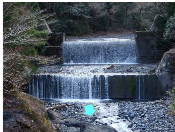
流木捕捉工設置前 (H27撮影)
