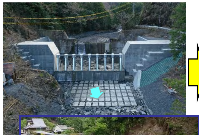
流木捕捉工設置後 (H30撮影)
