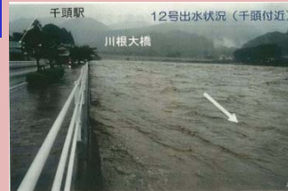
平成23年台風12号による大井川の出水状況(川根本町 千頭駅付近)
