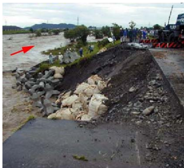
堤防の一部損傷
