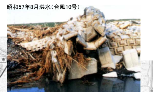
洪水時の低水護岸 被災状況
