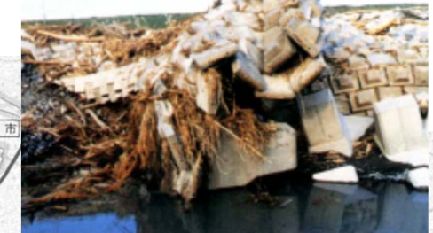
洪水時の低水護岸 被災状況
