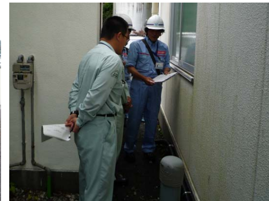
設備機器類点検の実地指導
