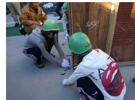
型枠の倒れ確認の体験
