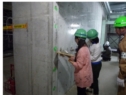
コーンのモルタル埋め体験
