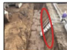
オープンカット法面整形(60° 3D)
