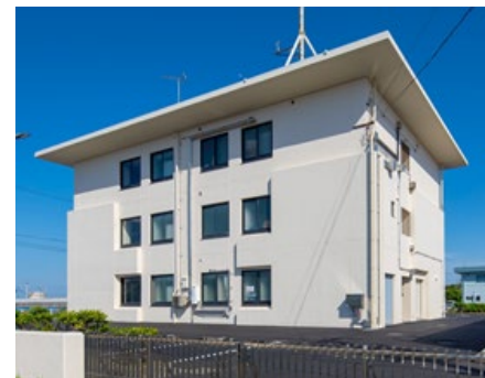
波圧補強（壁増打）、自家発3階移転 【御前崎港湾合同庁舎】
