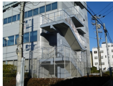
津波避難用の屋外階段を新設 【清水地方合同庁舎】
