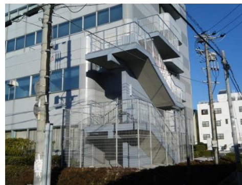
津波避難用の屋外階段を新設
