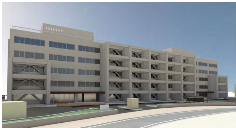
静岡地方合同庁舎・法務総合庁舎耐震改修
