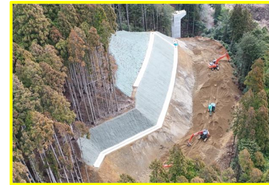
⑤ 川向地区道路建設
