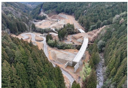
西地橋～小松トンネル日掛トンネル
