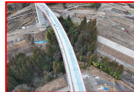
④ 4号橋PC上部工
