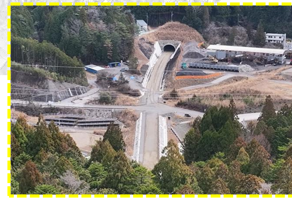
② 清崎地区舗装工事 工事起点付近 ～安沢トンネル入口付近
