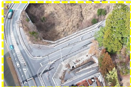
工事起点～土工1工区
