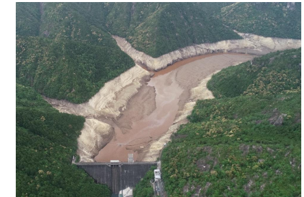
令和元年の渇水時の宇連ダム（令和元年5月）
