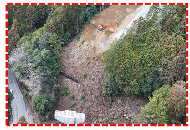
③ 5・6号橋下部工事 5号橋A2
