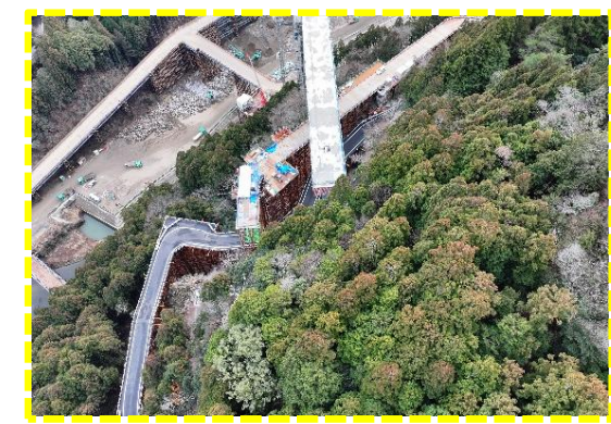
③ 松戸地区道路建設工事
