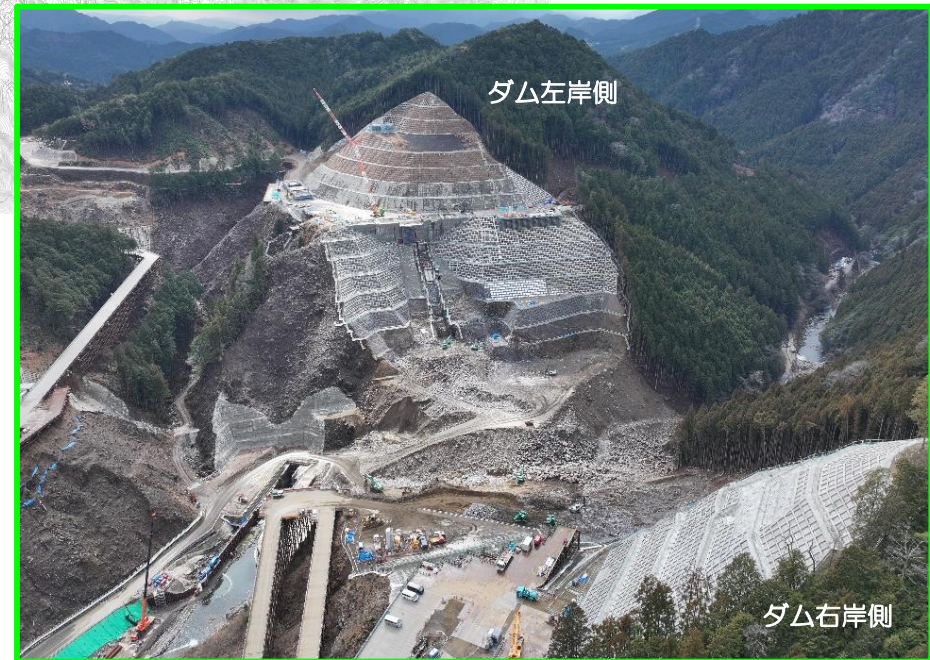
ダム本体I期工事
