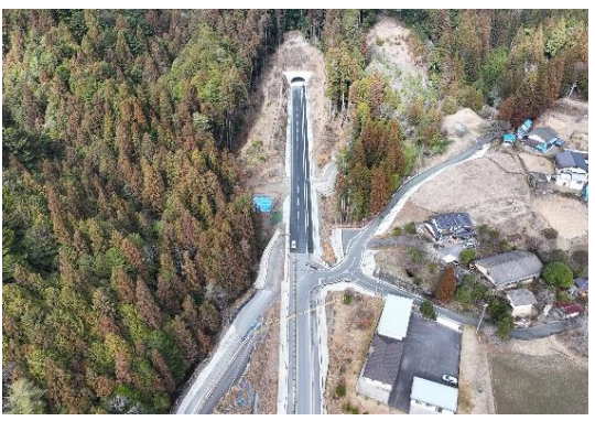
土工3工区～小松トンネル
