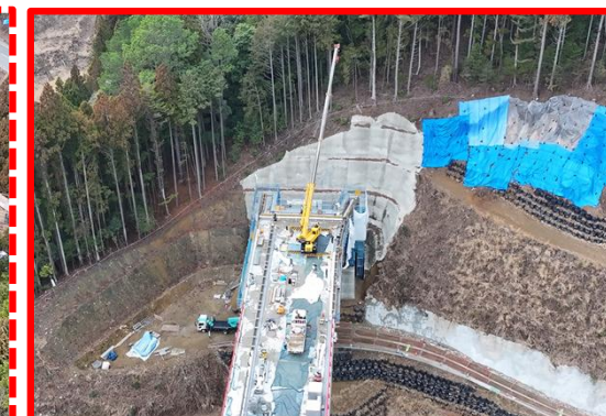
③ 4号橋下部工(A2橋台)
