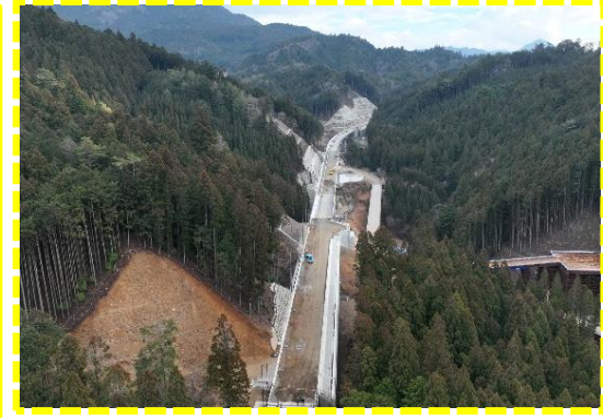
② 長江地区道路建設工事
