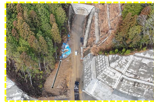
② 清崎地区舗装工事 安沢トンネル出口付近
