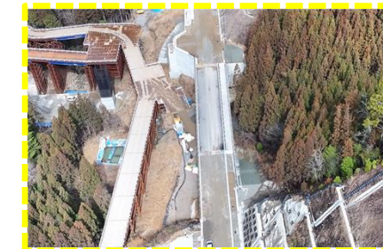
土工5工区～大平橋～土工6工区
