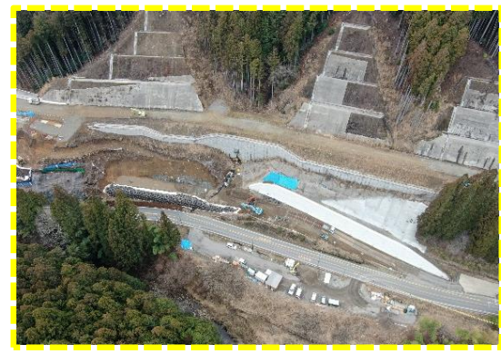
④ 八橋地区北部道路建設工事
