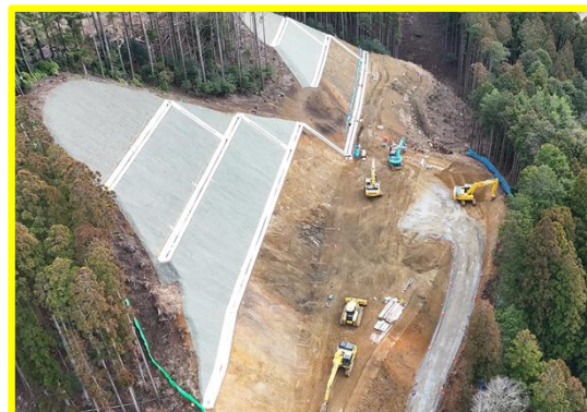
① 田口地区道路建設
