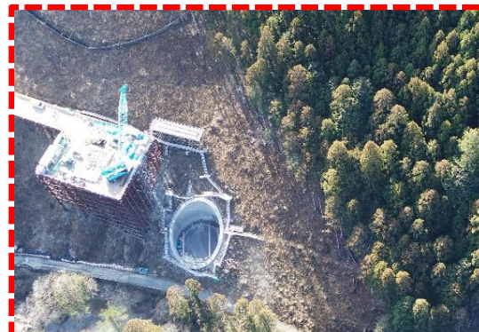
① 3号橋下部工事
