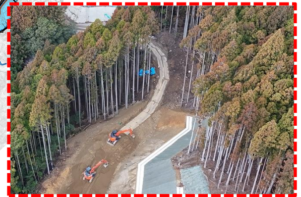
③ 5・6号橋下部工事 6号橋A1
