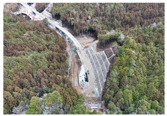
小松トンネル～大平橋
