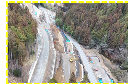
設楽根羽線接続部 工事終点
