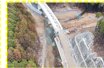
土工4工区～滝坂橋
