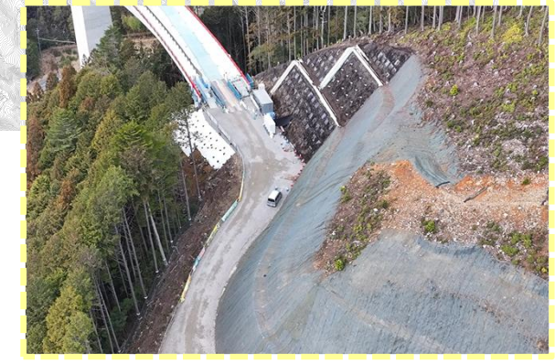
② 小松地区道路建設工事
