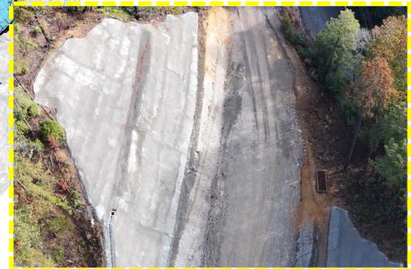
② 清崎地区舗装工事 工事終点付近
