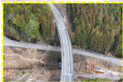
後口橋～土工2工区
