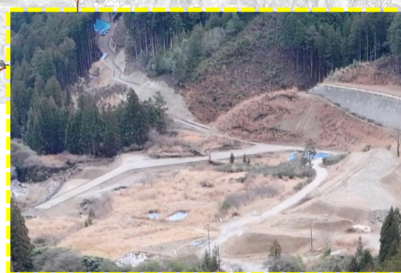
① 大名倉地区道路建設工事
