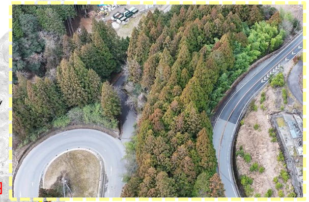
④ 下戸神地区道路建設工事
