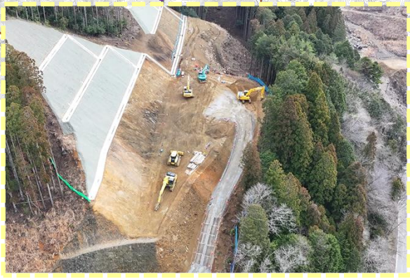
① 添沢地区道路建設工事
