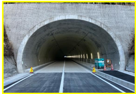
① 小松地区舗装工事
