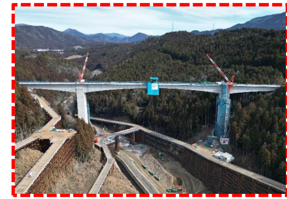
④ 5号橋PC上部工事
