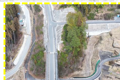
才ノ神橋～土工3工区
