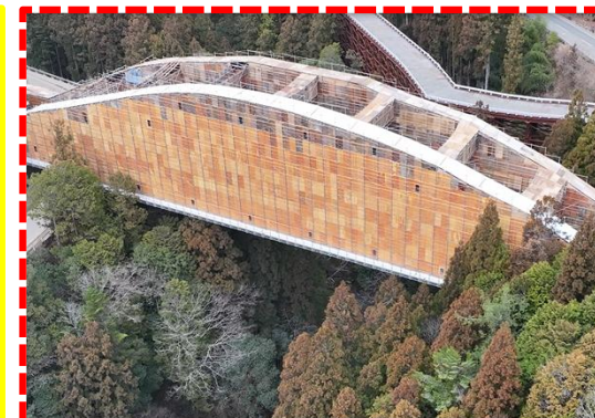
② 設楽大橋塗替工事
