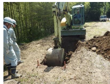
重機による試掘
