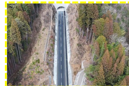
小松トンネル入口付近
