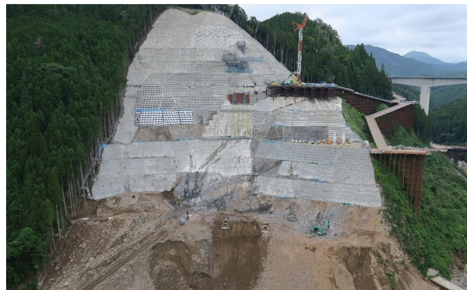
ダム本体右岸(2026年6月23日撮影)
