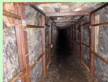
横坑内部の状況
