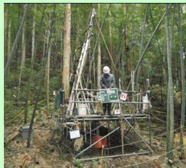
ボーリングマシンの写真
