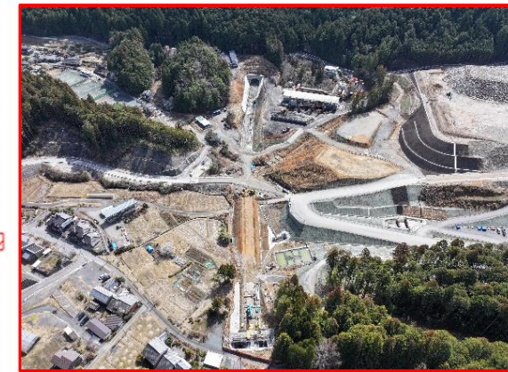
瀬戸設楽線4号トンネル（土工）
