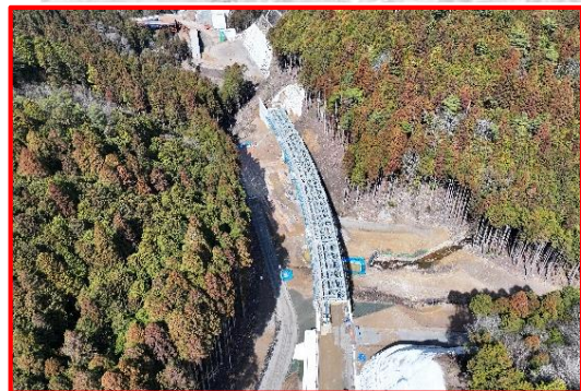
設楽根羽線3号橋上部工
