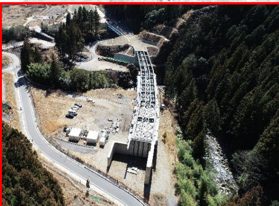
瀬戸設楽線床版（1号橋）
