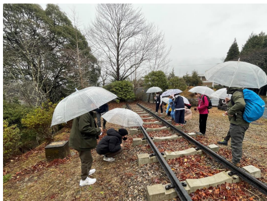
廃線となった田口線の遺構
