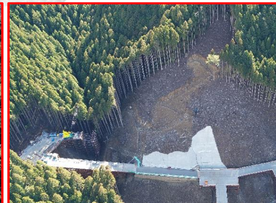
松戸地区橋梁下部工
