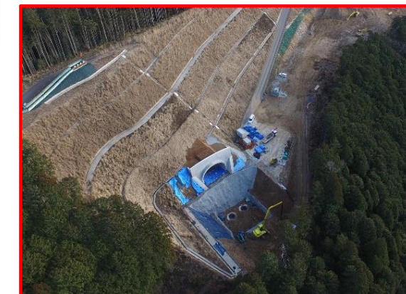
瀬戸設楽線4号トンネル（起点側）
