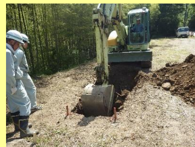
重機による試掘
