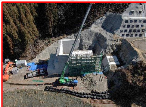
八橋地区道路建設工事（A2アプローチ）
