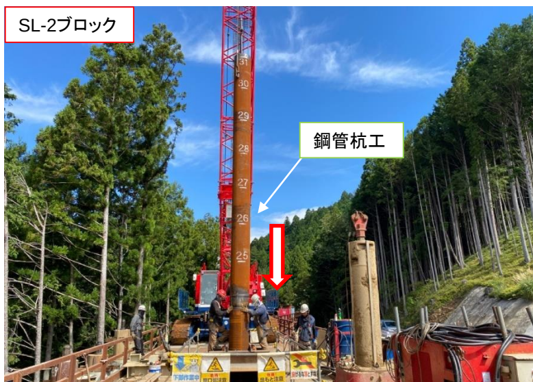
鋼管杭施工状況
