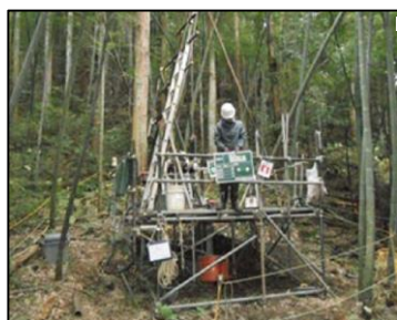
ボーリングマシンの写真
