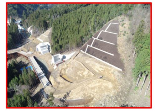
設楽根羽線3号橋右岸下部工（終点側）
