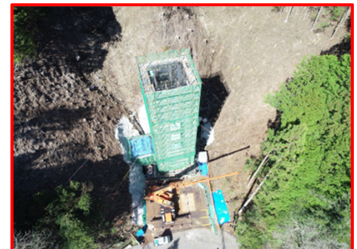
川向地区橋梁下部工
