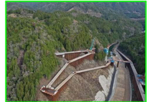
右岸工事用道路
