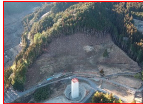
国道257号4号橋下部工
