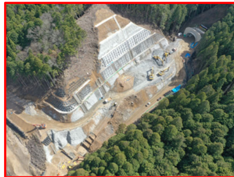
設楽根羽線3号橋左岸下部工（終点側）
