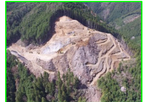
左岸頂部掘削
