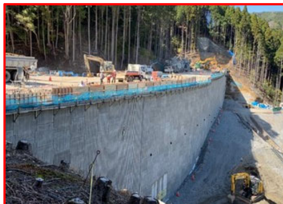
瀬戸設楽線1号トンネル（土工4工区）
