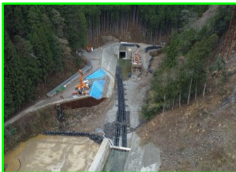
堤外仮排水路（呑口部）
