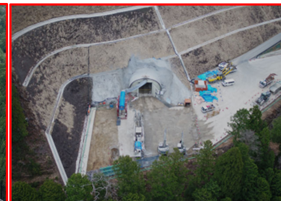
瀬戸設楽線4号トンネル（起点側）
