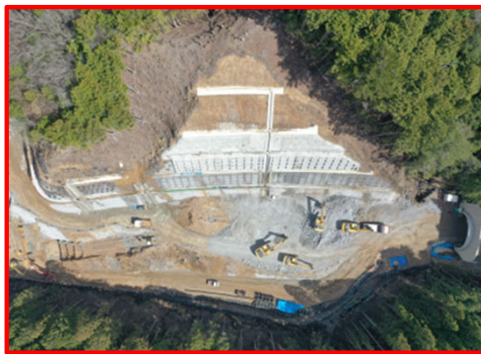
設楽根羽線3号橋左岸下部工（真上）
