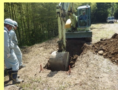
重機による試掘
