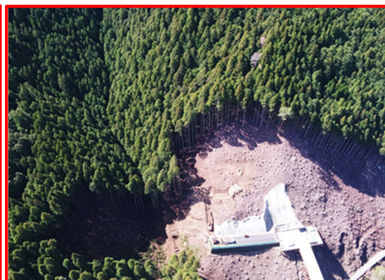
松戸地区橋梁下部工
