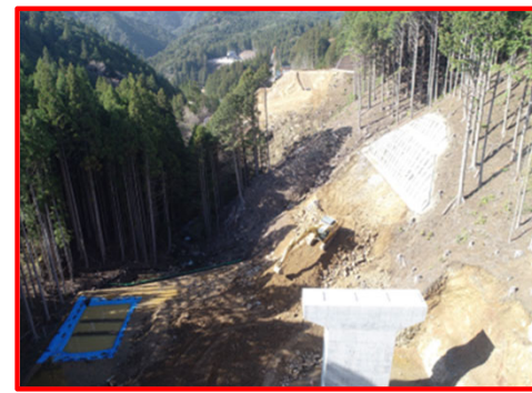
設楽根羽線3号橋右岸下部工（起点側）
