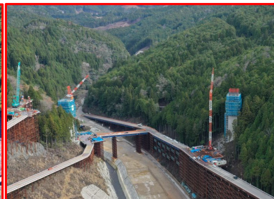
瀬戸設楽線5号橋下部工
