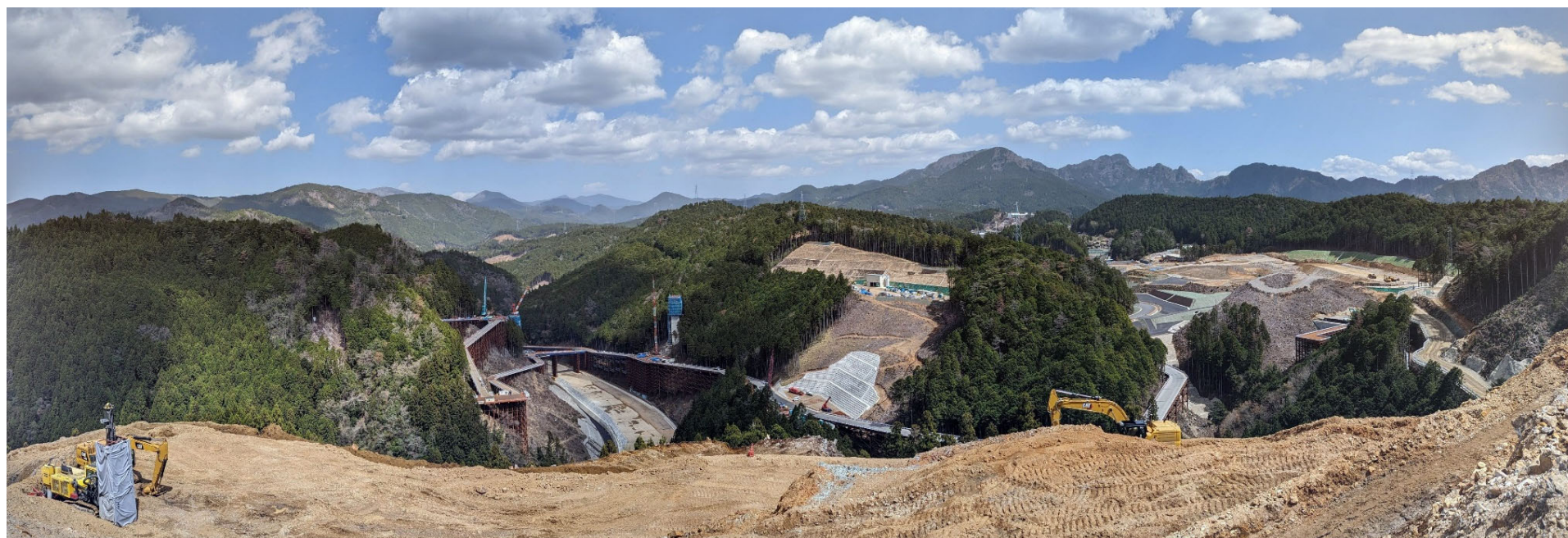
ダムサイト左岸頂部より工事現場を望む（2023.3.29撮影）
