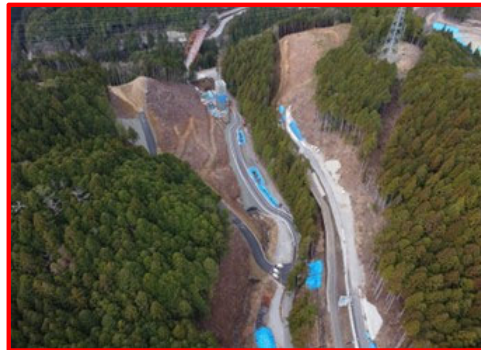
国道257号小松地区道路建設
