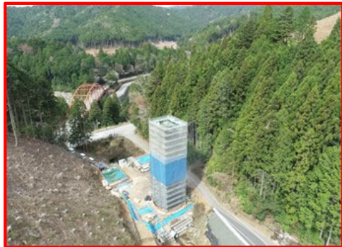
国道257号3号橋下部工
