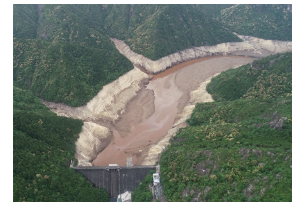
令和元年の渇水時の宇連ダム（令和元年5月）
