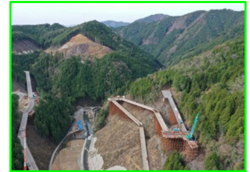
ダム本体施工箇所
