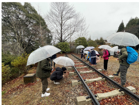
廃線となった田口線の遺構
