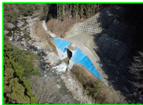
堤外仮排水路（吐口部）
