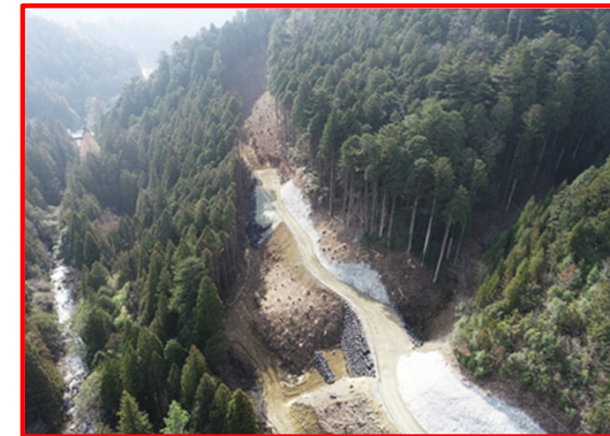
大名倉地区斜面对策(遠景)
