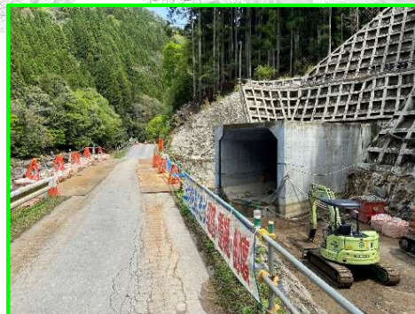
堤外仮排水路（吐口部）
