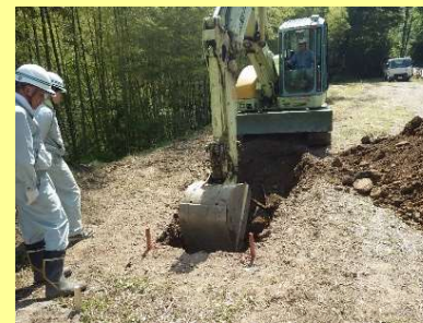
重機による試掘
