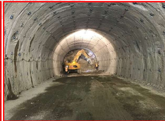
トンネル（1号・2号）
