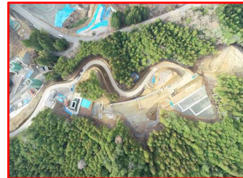
国道257号2号橋右岸下部工
