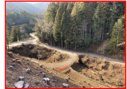
国道257号3号橋下部工
