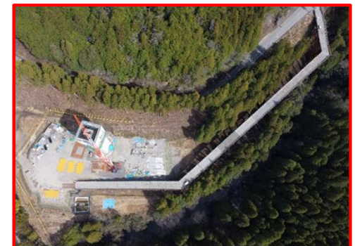
国道257号4号橋左岸下部工
