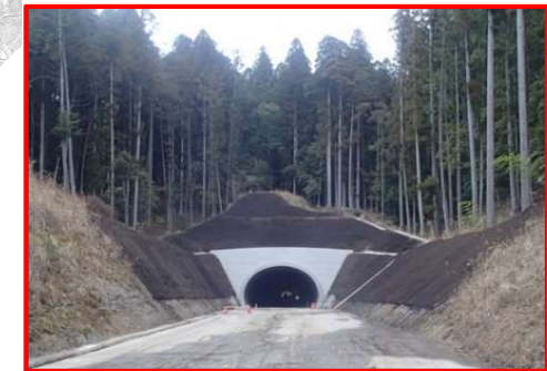
設楽根羽線1号トンネル坑口部完成
