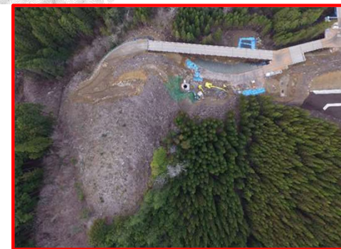
設楽根羽線4号橋下部工
