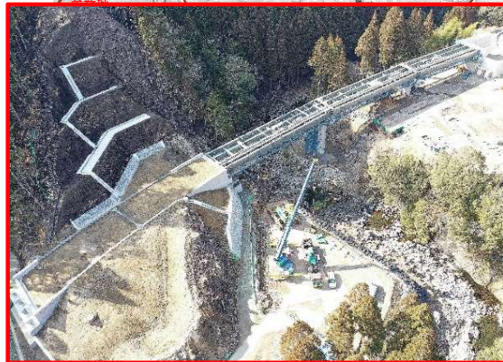
瀬戸設楽線1号橋上部工
