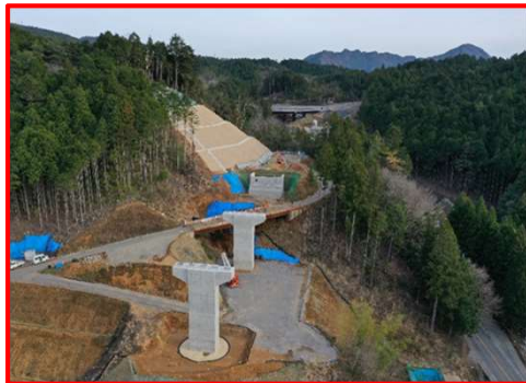
国道257号2号橋左岸下部工
