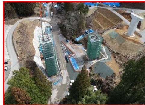
国道257号添沢地区橋梁下部工
