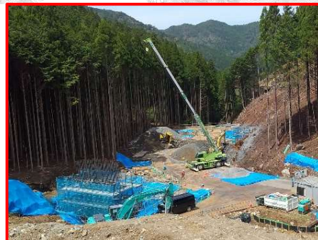
設楽根羽線3号橋（橋脚部）
