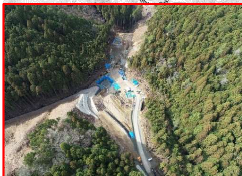
設楽根羽線3号橋下部工
