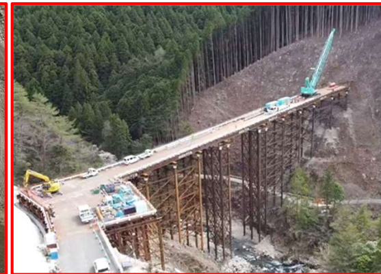
松戸地区工事用進入路
