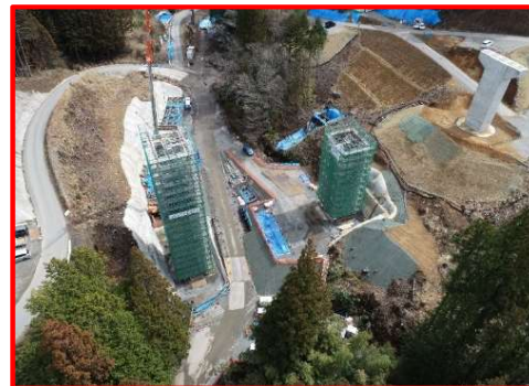
国道257号添沢地区橋梁下部工
