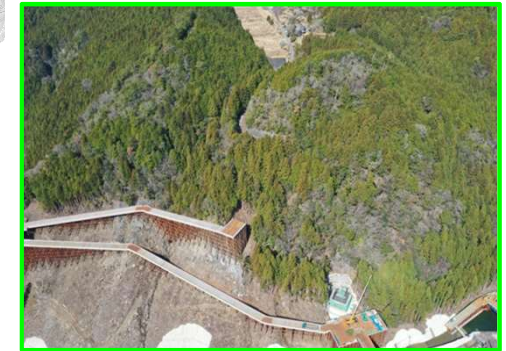
右岸工事用道路
