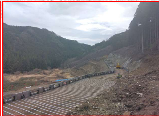
大名倉地区道路建設
