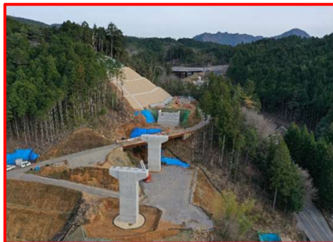
国道257号2号橋左岸下部工
