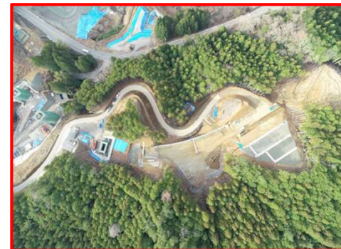
国道257号2号橋右岸下部工
