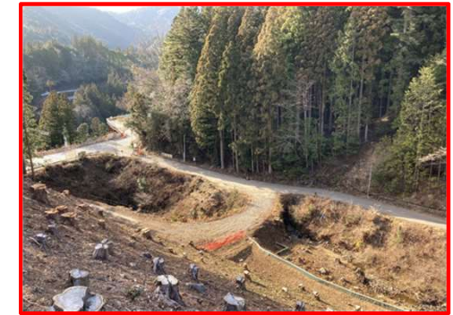
国道257号3号橋下部工
