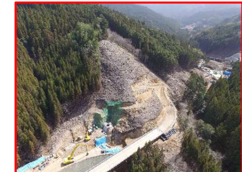
設楽根羽線4号橋（土工部）
