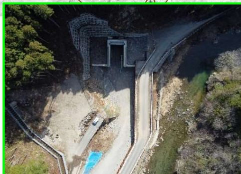
堤外仮排水路（呑口部）
