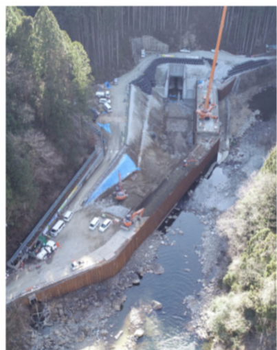
転流工呑口全景
