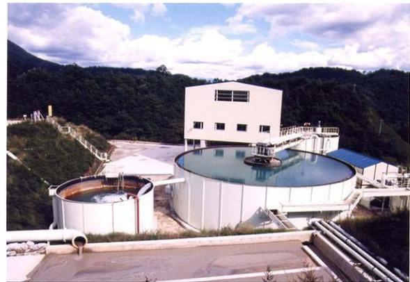
工事中には、ダム の 堤 体 の 工 事 等 に よ り 発 生 す る 濁 水 を 処 理 す る た め の 濁 水 処 理 設 備 や pH 調 節 施 設 を 設 置 し て、水 質 に 対 す る 影 響 を 抑 制 し ま す。
