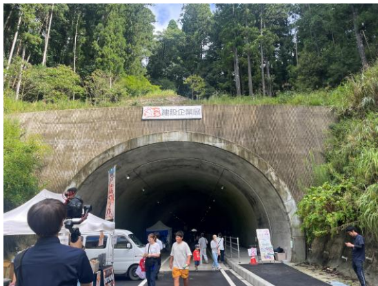
トンネル正面出入り口
