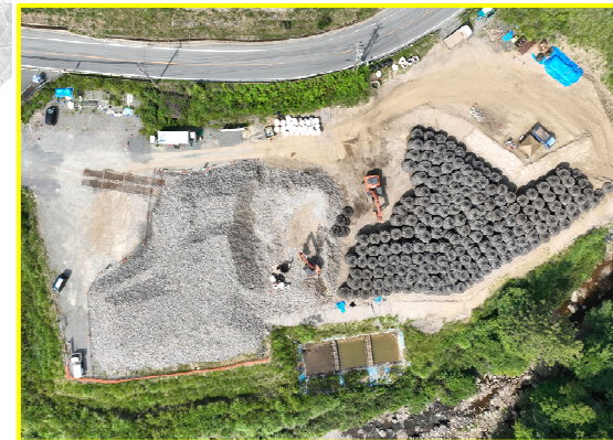
③八橋地区南部道路建設
