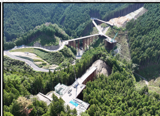
瀬戸設楽線2号トンネルから4号橋
