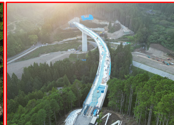
②4号橋PC上部工
