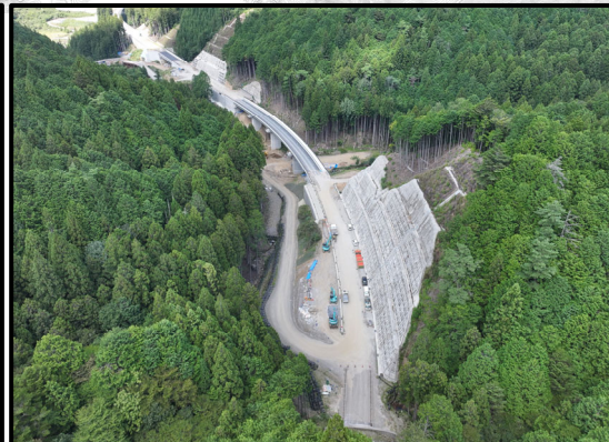
設楽根羽線1号トンネルから4号橋
