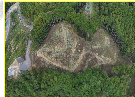
③田口地区道路建設
