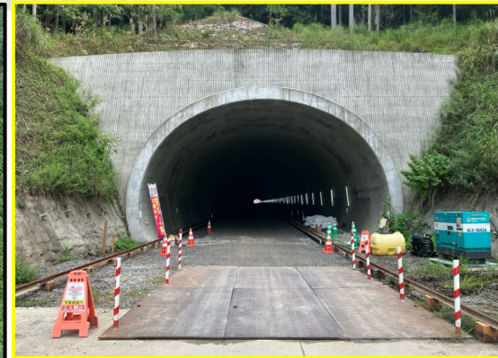
①小松地区舗装
