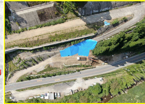
④八橋地区北部道路建設
