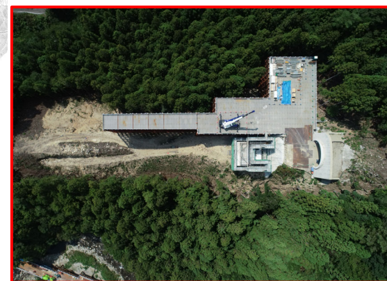
①R5・3号橋下部工
