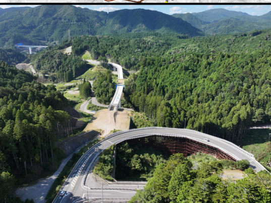
257号起点から設楽大橋
