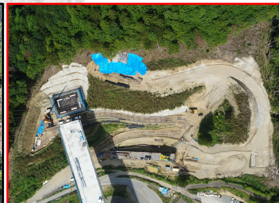
①4号橋下部工(A2橋台)
