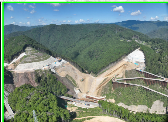
①本体建設第1期(上流側より)
