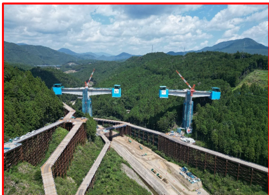
⑤5号橋PC上部工
