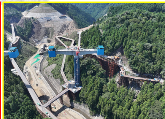
④松戸地区道路建設
