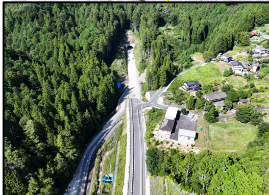
設楽根羽土工3工区から1号トンネル
