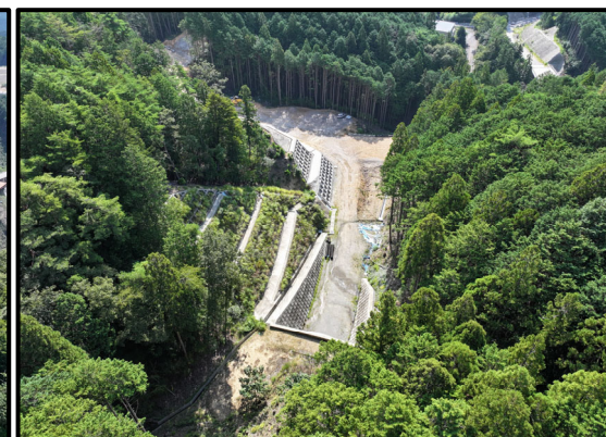
5号トンネルから国道257号
