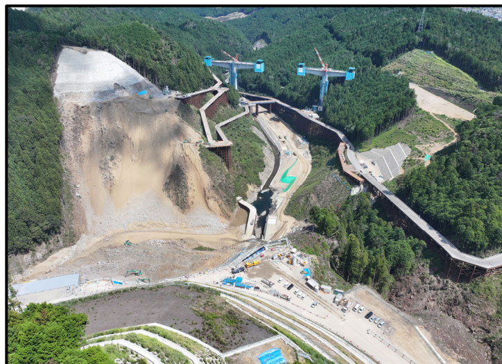
① 左岸頂部より
