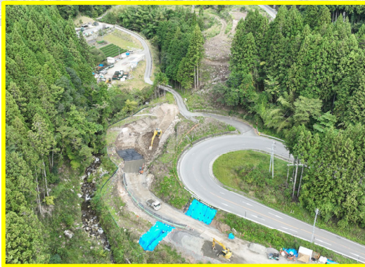
⑤下戸神地区道路建設工事
