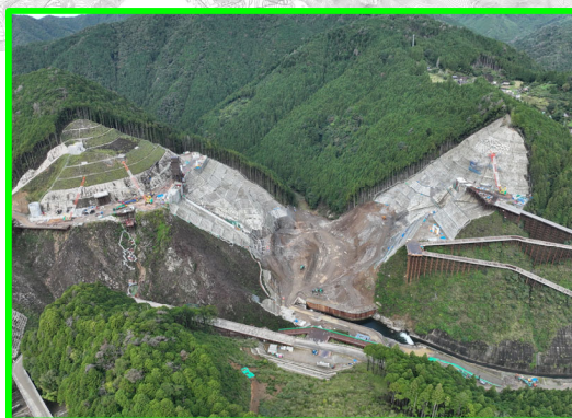
①本体建設第1期工事(上流側より)
