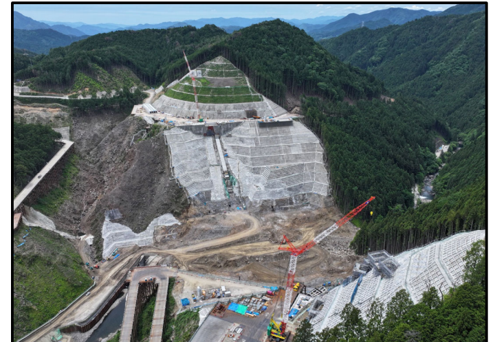
③ 右岸頂部より
