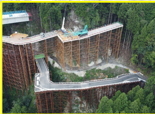
②松戸地区道路建設工事
