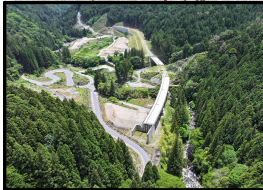
瀬戸設楽線1号橋から1号トンネル
