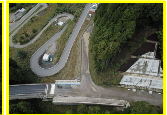
①田口八橋地区道路建設工事【大野線接続部】
