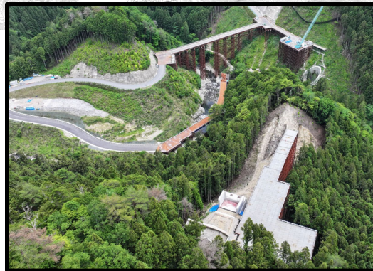
瀬戸設楽線2号トンネルから3号橋
