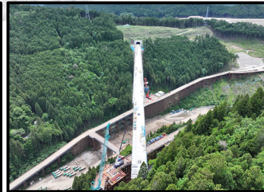
瀬戸設楽線5号橋から4号トンネル
