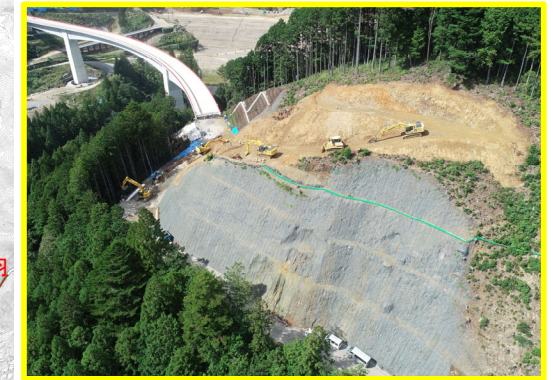
③小松地区道路建設工事
