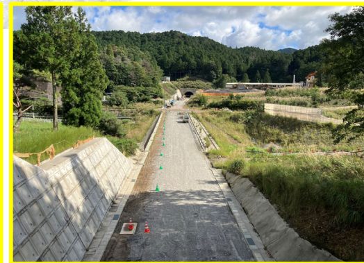
③清崎地区舗装工事
