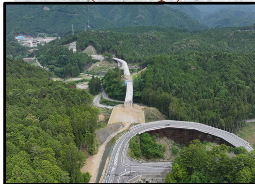
257号起点から設楽大橋
