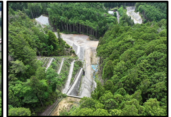
5号トンネルから国道257号
