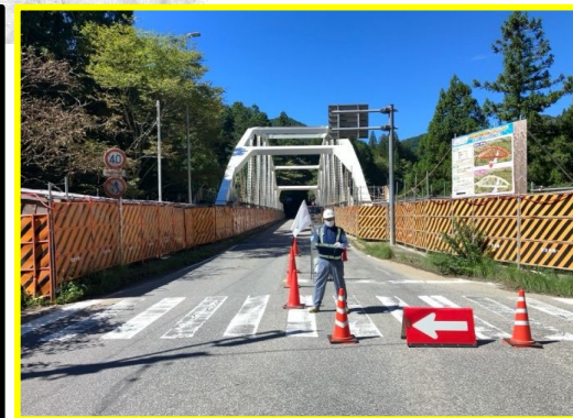
①設楽大橋塗替工事
