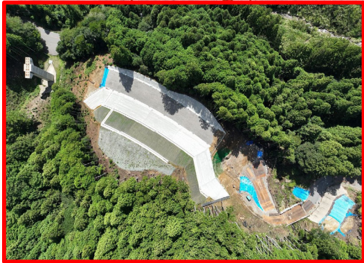
④5·6号橋下部工事
