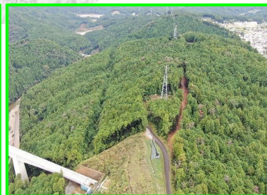
②田口地区斜面对策進入路工事
