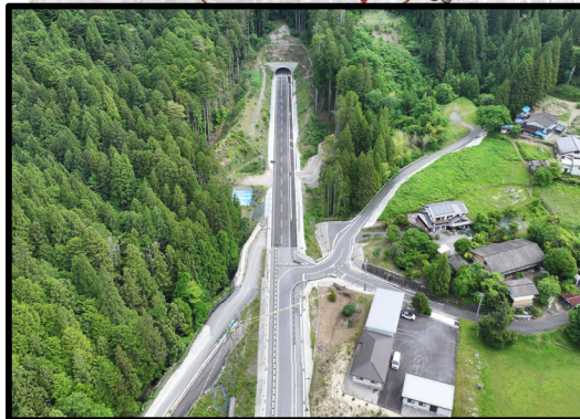
設楽根羽土工3工区から1号トンネル
