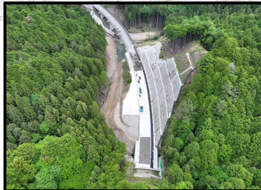
設楽根羽線1号トンネルから4号橋
