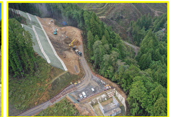
②添沢地区道路建設工事【添沢工区】
