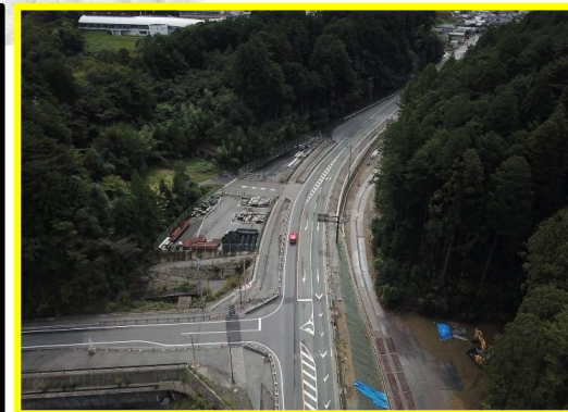
①田口八橋地区道路建設工事【起点部】
