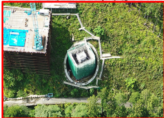
①3号橋下部工事
