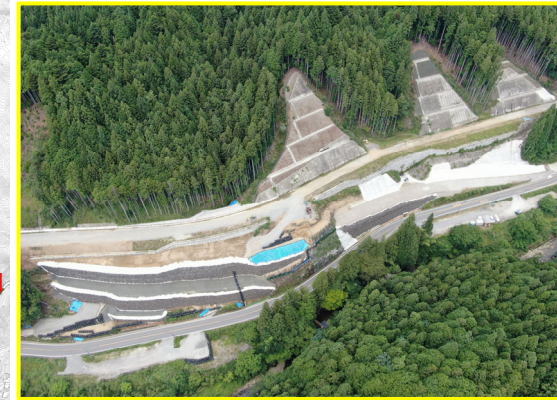
②八橋地区北部道路建設工事
