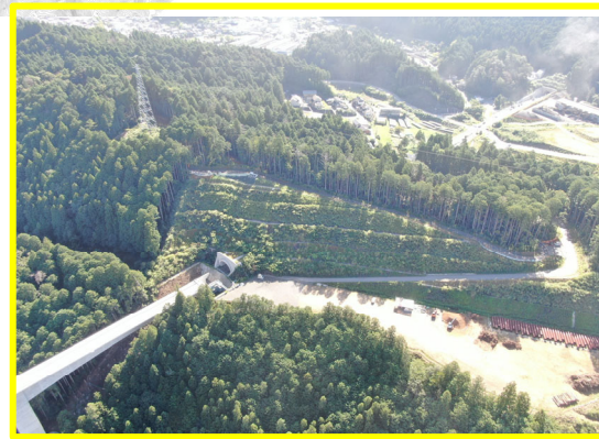
② 田口地区斜面对策進入路工事
