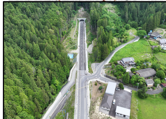
設楽根羽土工3工区から1号トンネル
