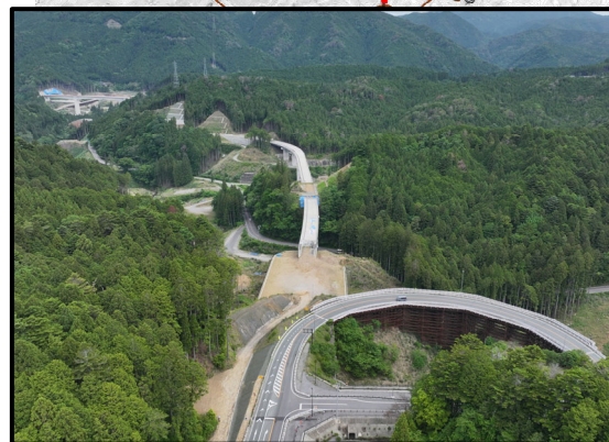
257号起点から設楽大橋
