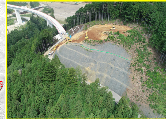
③小松地区道路建設工事
