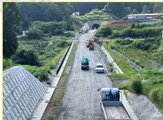
③清崎地区舗装工事
