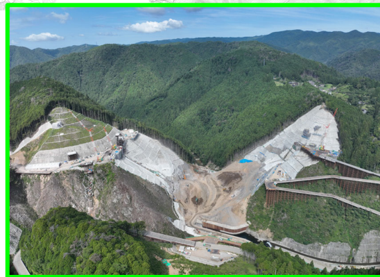
① 本体建設第1期工事(上流側より)
