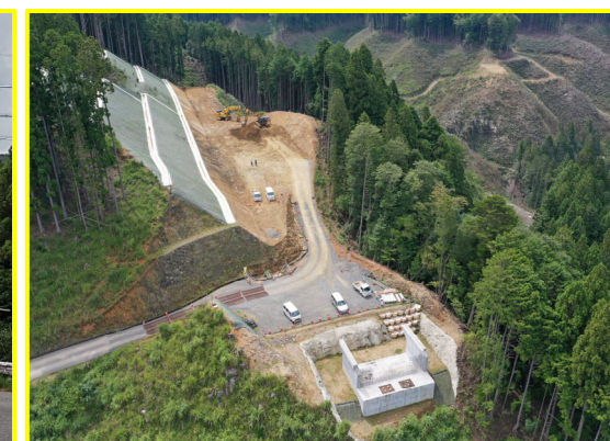
②添沢地区道路建設工事【添沢工区】
