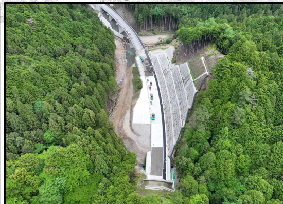
設楽根羽線1号トンネルから4号橋
