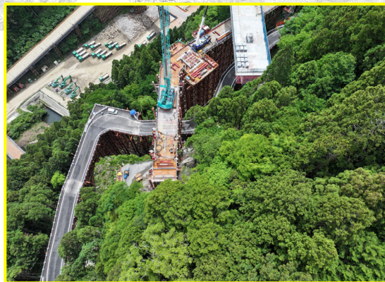
②松戸地区道路建設工事
