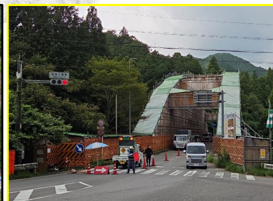
①設楽大橋塗替工事
