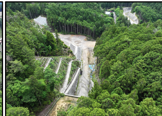
5号トンネルから国道257号
