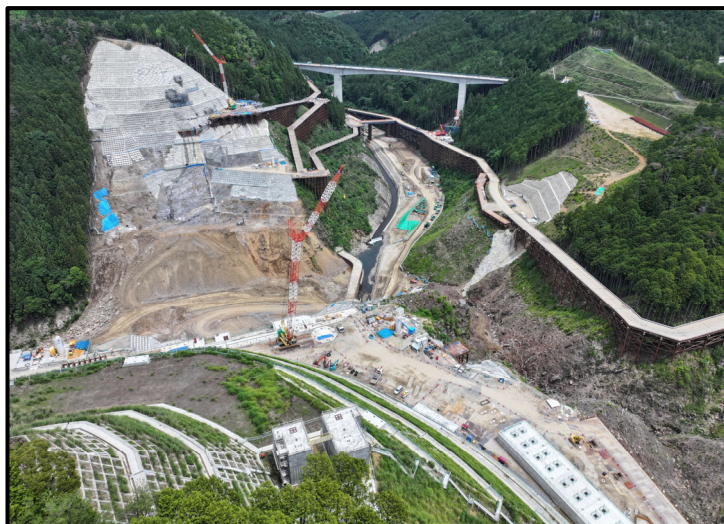
① 左岸頂部より
