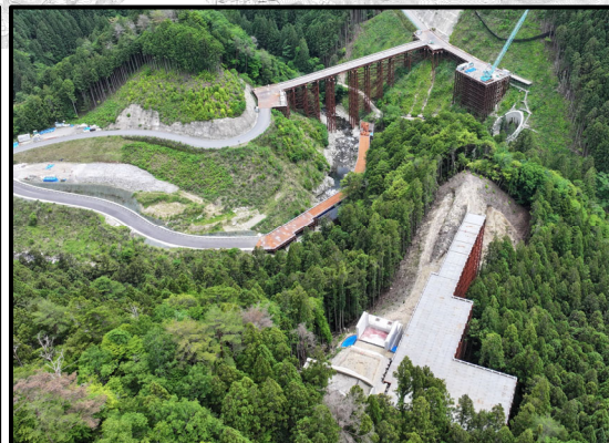
瀬戸設楽線2号トンネルから3号橋
