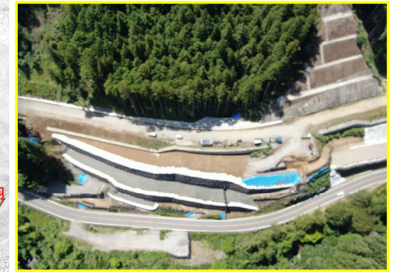
②八橋地区北部道路建設工事
