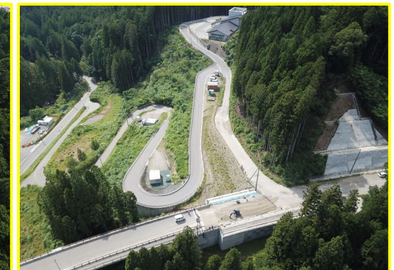
①田口八橋地区道路建設工事【大野線接続部】
