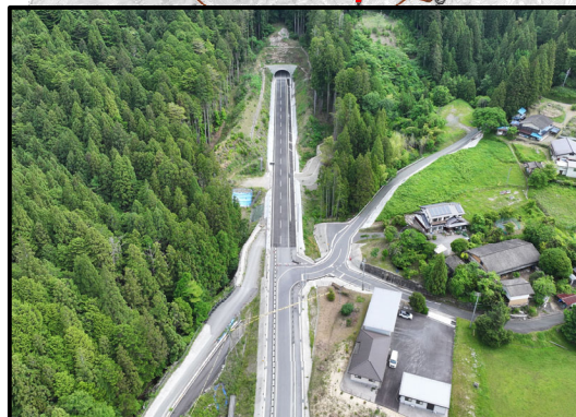
設楽根羽土工3工区から1号トンネル
