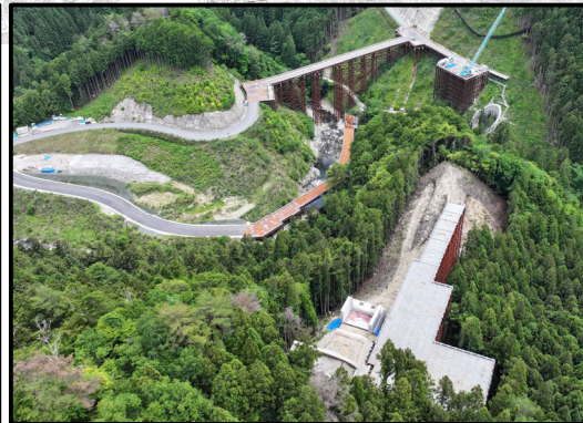
瀬戸設楽線2号トンネルから3号橋
