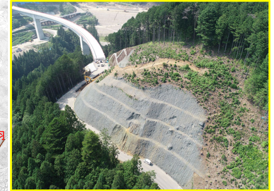
③小松地区道路建設工事
