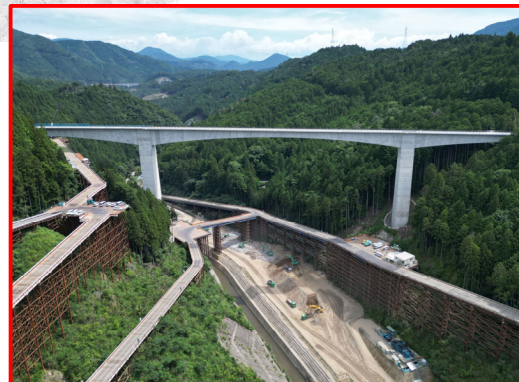
③5号橋PC上部工事
