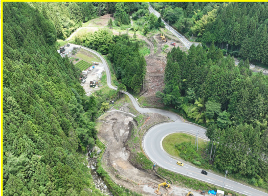
⑤下戸神地区道路建設工事
