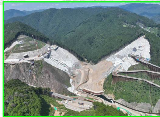
① 本体建設第1期工事(上流側より)
