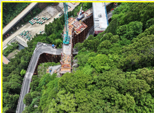
②松戸地区道路建設工事
