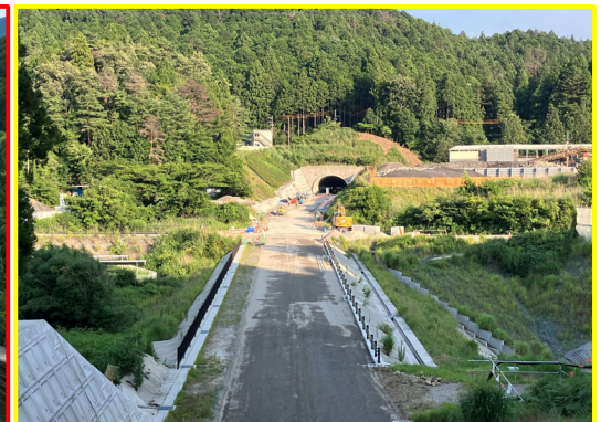
④清崎地区舗装工事
