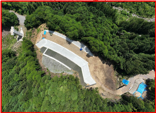
④5·6号橋下部工事
