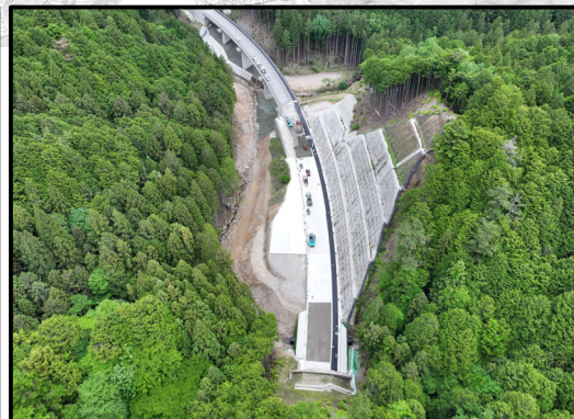
設楽根羽線1号トンネルから4号橋
