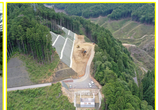
②添沢地区道路建設工事【添沢工区】
