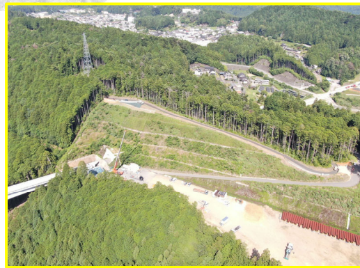
② 田口地区斜面对策進入路工事
