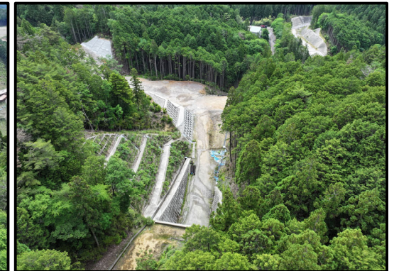
5号トンネルから国道257号
