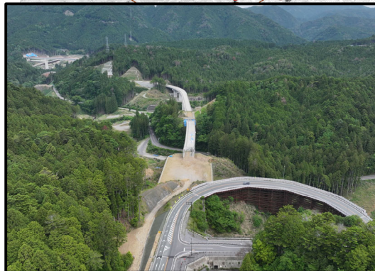
257号起点から設楽大橋
