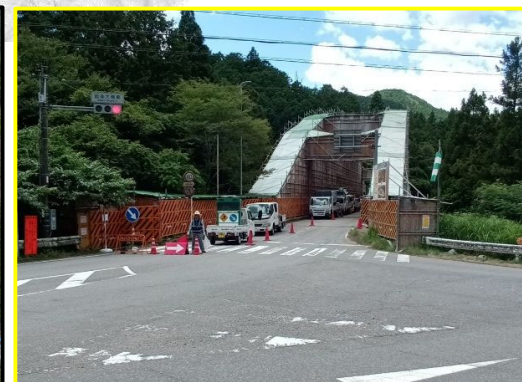
①設楽大橋塗替工事
