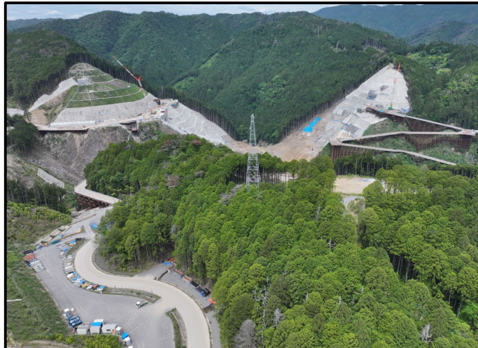
② 上流側より
