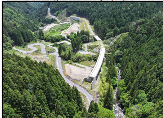
瀬戸設楽線1号橋から1号トンネル
