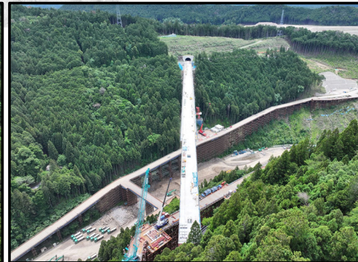
瀬戸設楽線5号橋から4号トンネル
