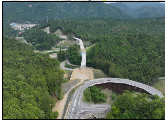
257号起点から設楽大橋
