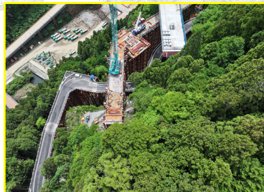
②松戸地区道路建設工事
