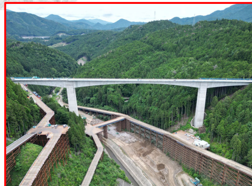
③5号橋PC上部工事
