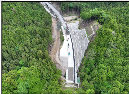
設楽根羽線1号トンネルから4号橋
