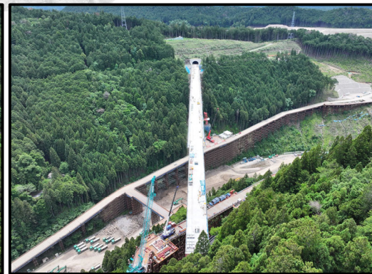
瀬戸設楽線5号橋から4号トンネル
