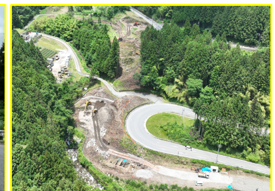
② 下戸神地区道路建設工事
