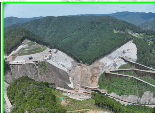
① 本体建設第1期工事(上流側より)
