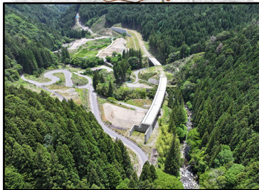
瀬戸設楽線1号橋から1号トンネル
