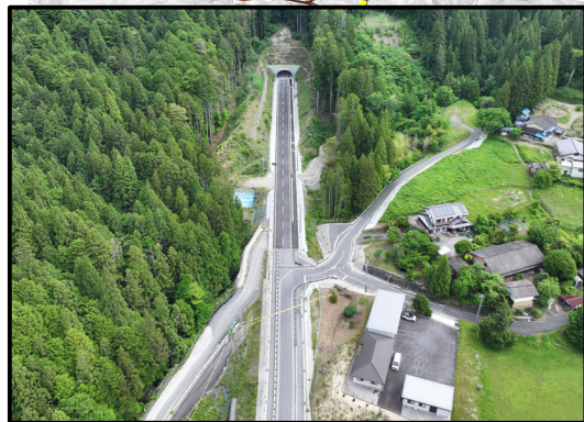
設楽根羽土工3工区から1号トンネル
