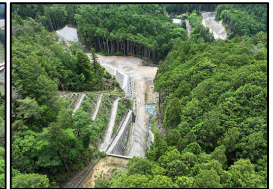
5号トンネルから国道257号
