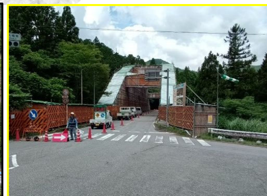
① 設楽大橋塗替工事
