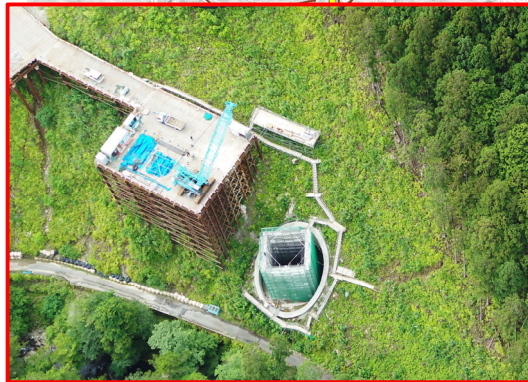
①R6・3号橋下部工事
