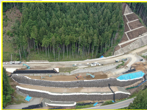
①八橋地区北部道路建設工事
