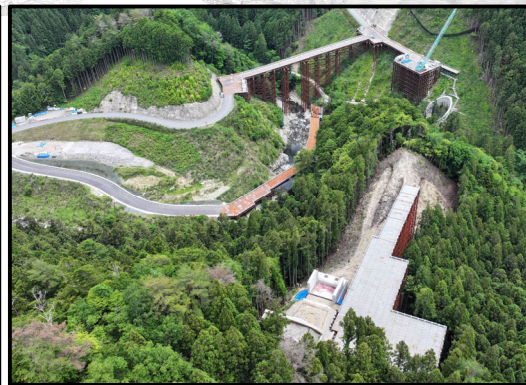
瀬戸設楽線2号トンネルから3号橋
