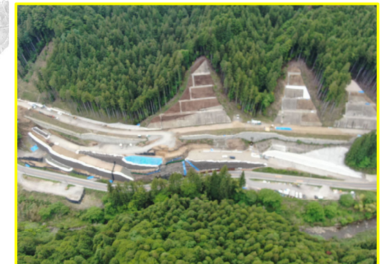
③八橋地区北部道路建設
