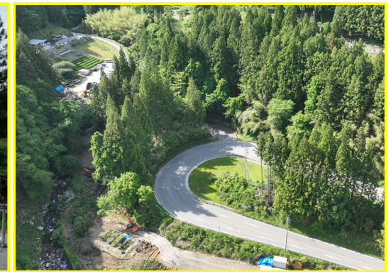
② 下戸神地区道路建設
