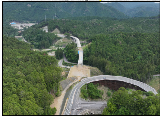
257号起点から設楽大橋
