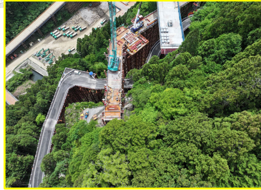
②松戸地区道路建設
