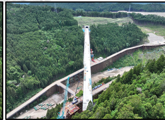
瀬戸設楽線5号橋から4号トンネル
