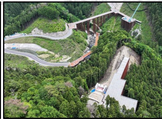
瀬戸設楽線2号トンネルから3号橋
