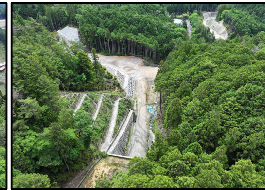
5号トンネルから国道257号
