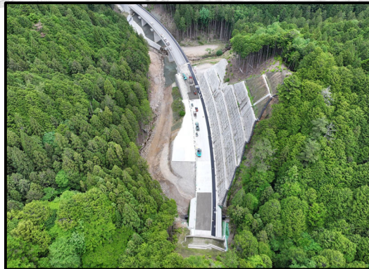
設楽根羽線1号トンネルから4号橋
