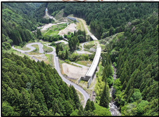
瀬戸設楽線1号橋から1号トンネル
