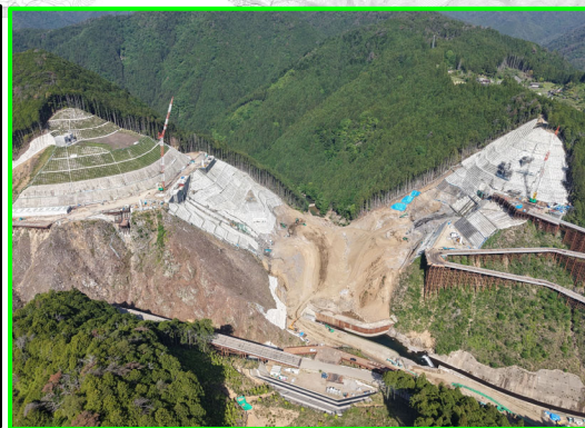
① 本体建設第1期(上流側より)
