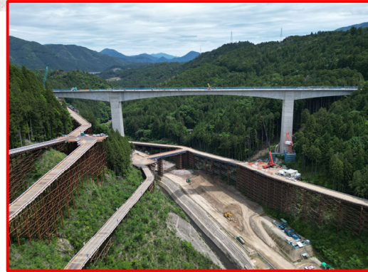
③5号橋PC上部工
