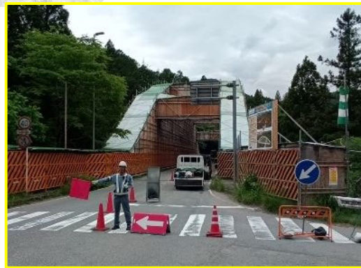
① 設楽大橋塗替工事
