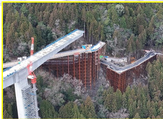
②松戸地区道路建設
