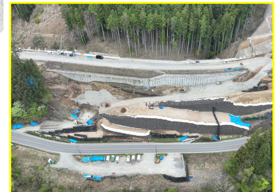
③八橋地区南部道路建設
