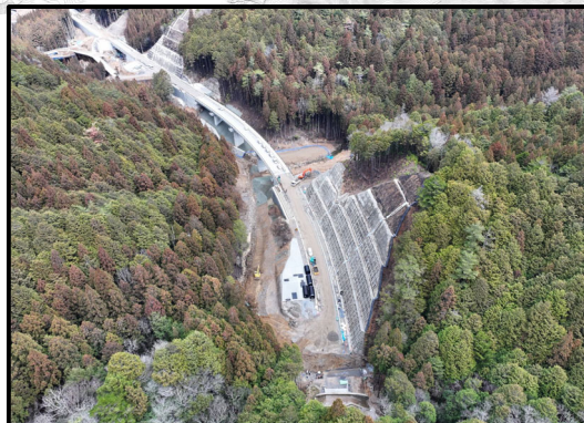
設楽根羽線1号トンネルから4号橋
