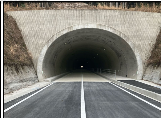
①小松地区舗装工事
