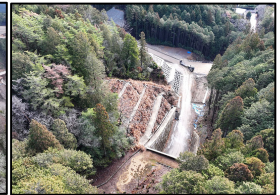
5号トンネルから国道257号
