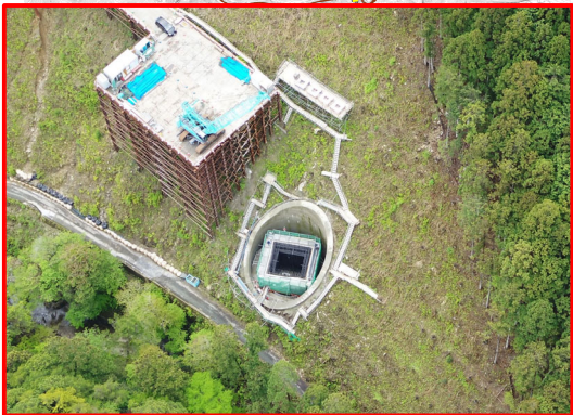
①R6・3号橋下部工
