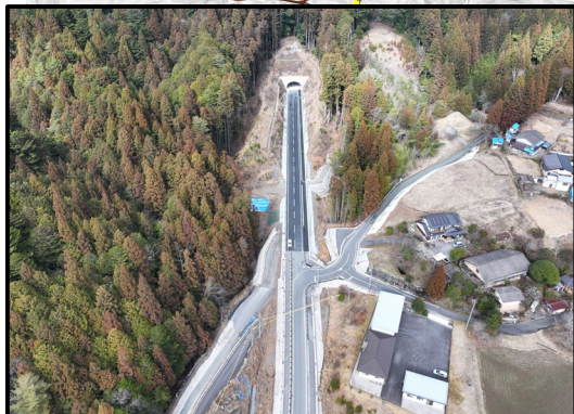
設楽根羽土工3工区から1号トンネル
