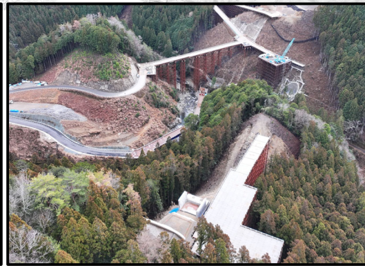
瀬戸設楽線2号トンネルから3号橋
