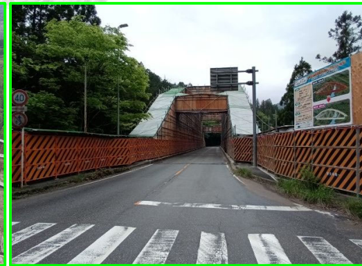
② 設楽大橋塗替工事
