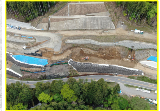
④八橋地区北部道路建設
