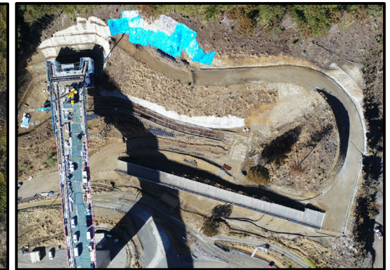
② 4号橋下部工(A2橋台)
