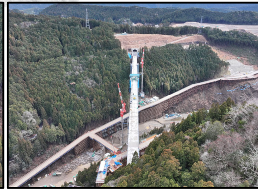
瀬戸設楽線5号橋から4号トンネル
