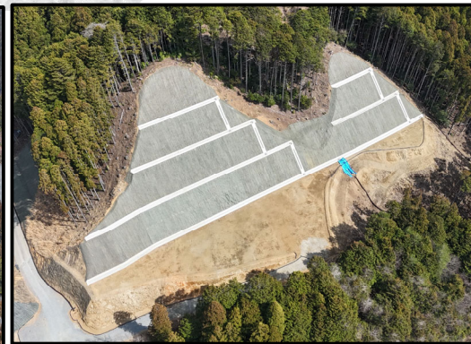
①田口地区道路建設
