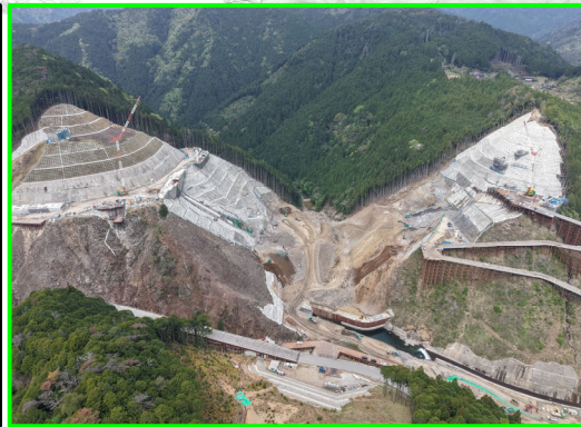
① 本体建設第1期(上流側より)
