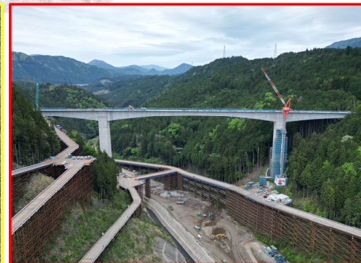
③5号橋PC上部工
