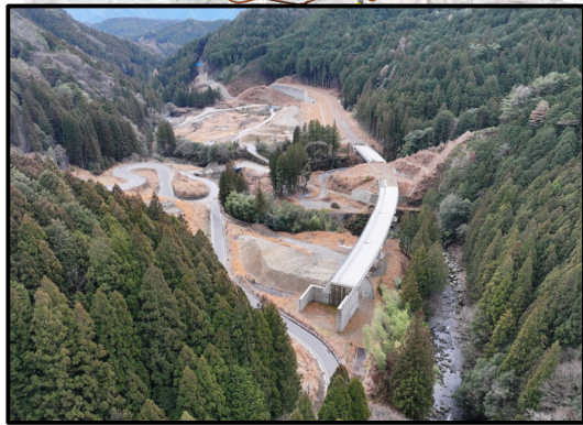
瀬戸設楽線1号橋から1号トンネル
