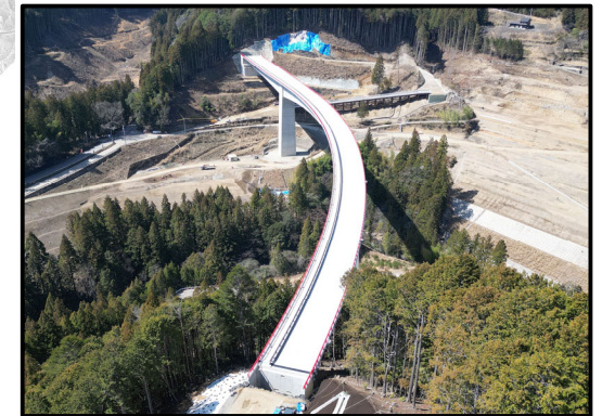
③ 4号橋PC上部工
