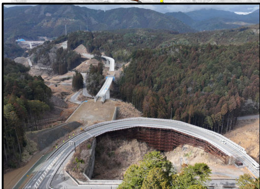
257号起点から設楽大橋
