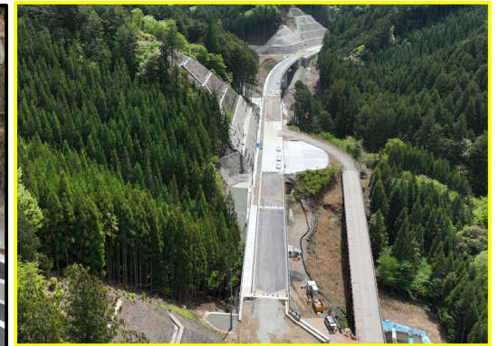
②長江地区道路建設
